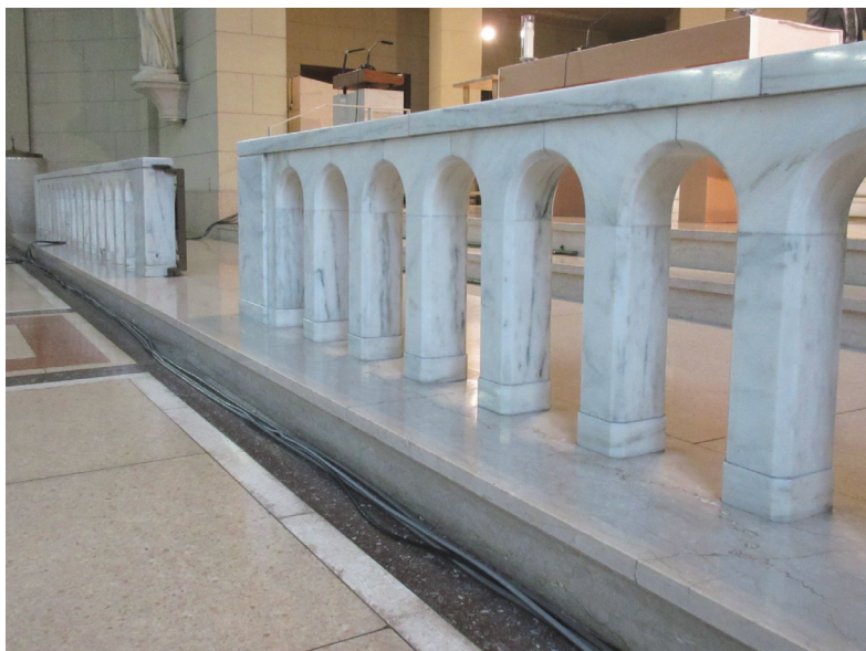
図5. 内陣への段上の柵（水戸寒水石）
