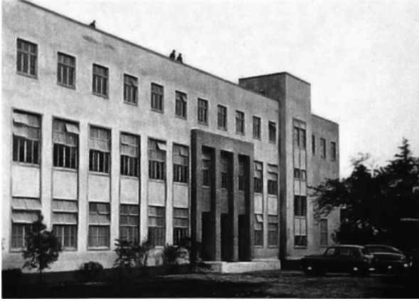
図4-6 竣工当時の1号館
